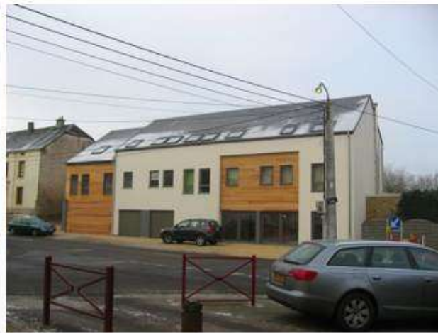
façade avant droite
