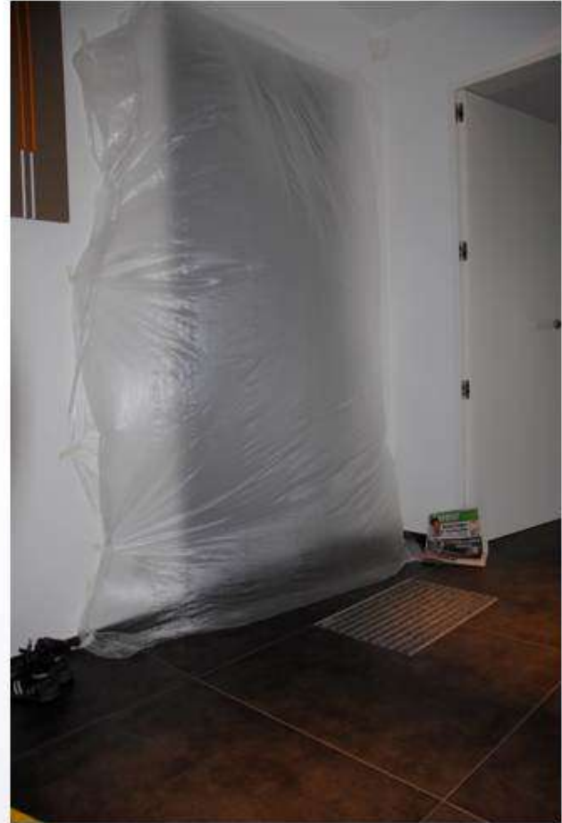
Etanchéité à l'air
