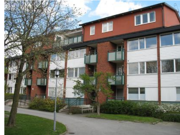
Logements locatifs rénovés de la ville dans le quartier de Varberga
