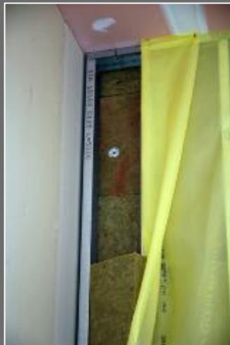
*Mise en œuvre de l'isolant en deux couches avec fixations isolantes*
