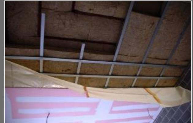
*Mise en œuvre de l'isolant en deux couches pour les toitures*
