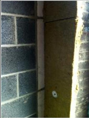
*Rupture des ponts thermiques au niveau des murs de refend*
