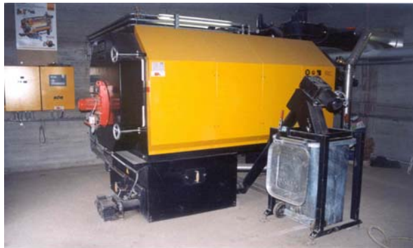
Figure 23 : Chaudière à plaquettes de bois avec, en premier plan, le conteneur de collecte et d'évacuation des cendres
