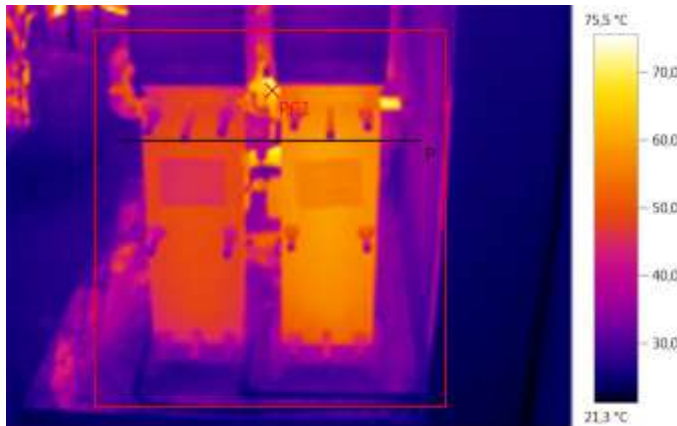
Figure 28 : Prise de vue par caméra thermographique dans les souterrains de Bracops (conduite chauffage radiateur couloirs et ECS) et dans la chaufferie du bloc E (échangeurs à plaque, ECS)
