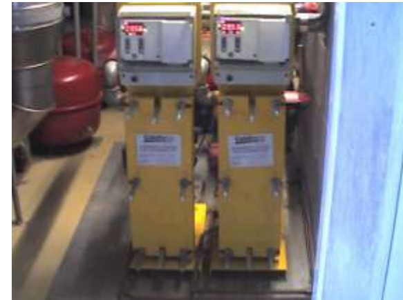
Figure 28 : Prise de vue par caméra thermographique dans les souterrains de Bracops (conduite chauffage radiateur couloirs et ECS) et dans la chaufferie du bloc E (échangeurs à plaque, ECS)
