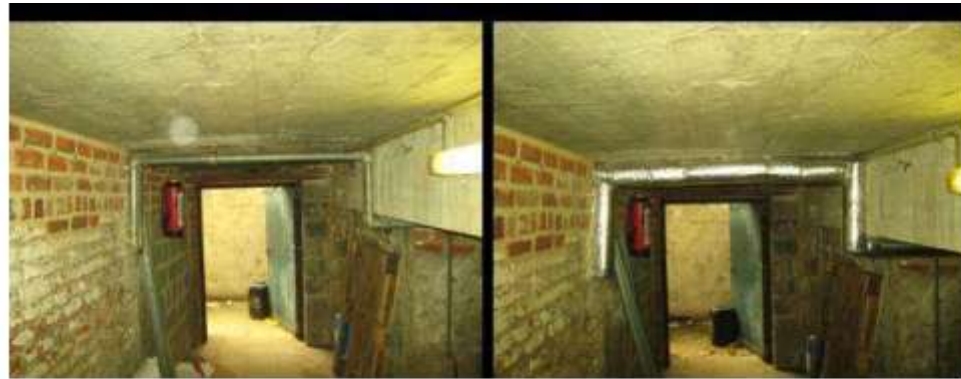
Isolation de tronçons de conduite (cave bâtiment J). Avant (gauche) et après (droite, 5cm isolant laine de roche)
